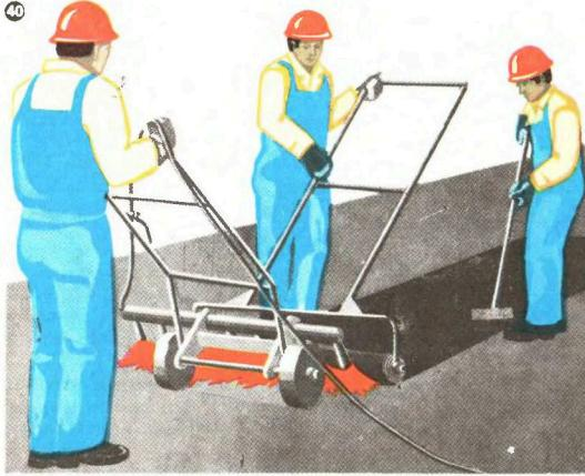
рубероида состоит из оси, скобы и ручки, при помощи которой рабочий равномерно, по мере подплавления мастики накатывает рулон на прогретое основание кровли. Чтобы устранить возможные зазоры между полотнищем рубероида и основанием кровли или нижележащим полотнищем, применяют виброкаток и гребок кровельщика.
